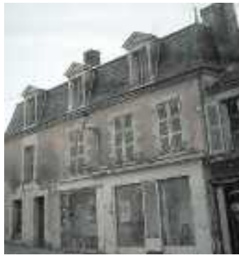
La maison avant travaux ...
