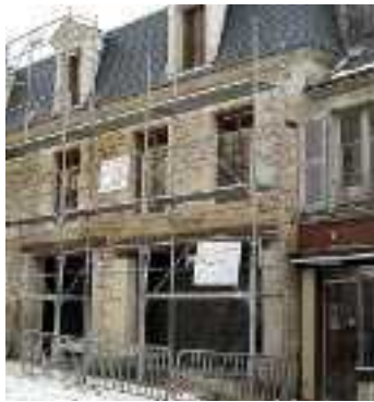
... actuellement en rénovation.
